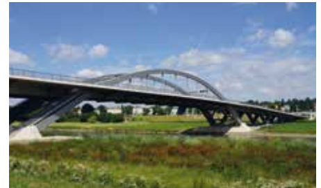
Waldschloesschen Bridge, Dresden / Germany
